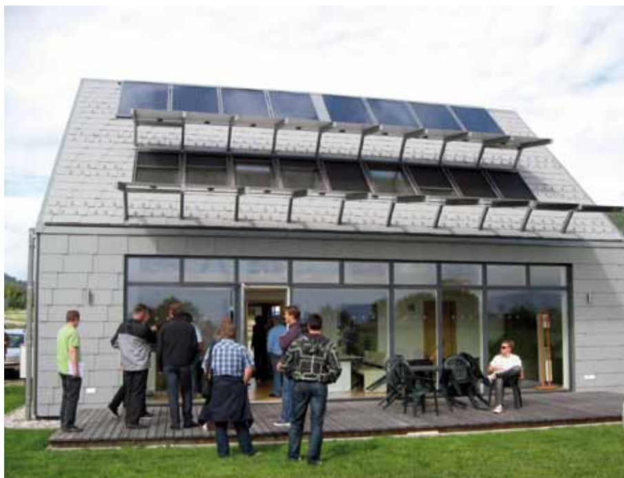
Slika 9 Južna stran, pod slemenom je vgrajena vrsta toplovodnih sprejemnikov sončne energije, na brisolejih pa fotovoltaični moduli
