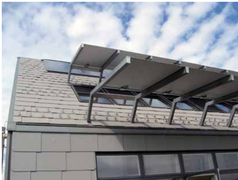
Slika 8 Vgradnja fotoelektričnih modulov na brisoleje
