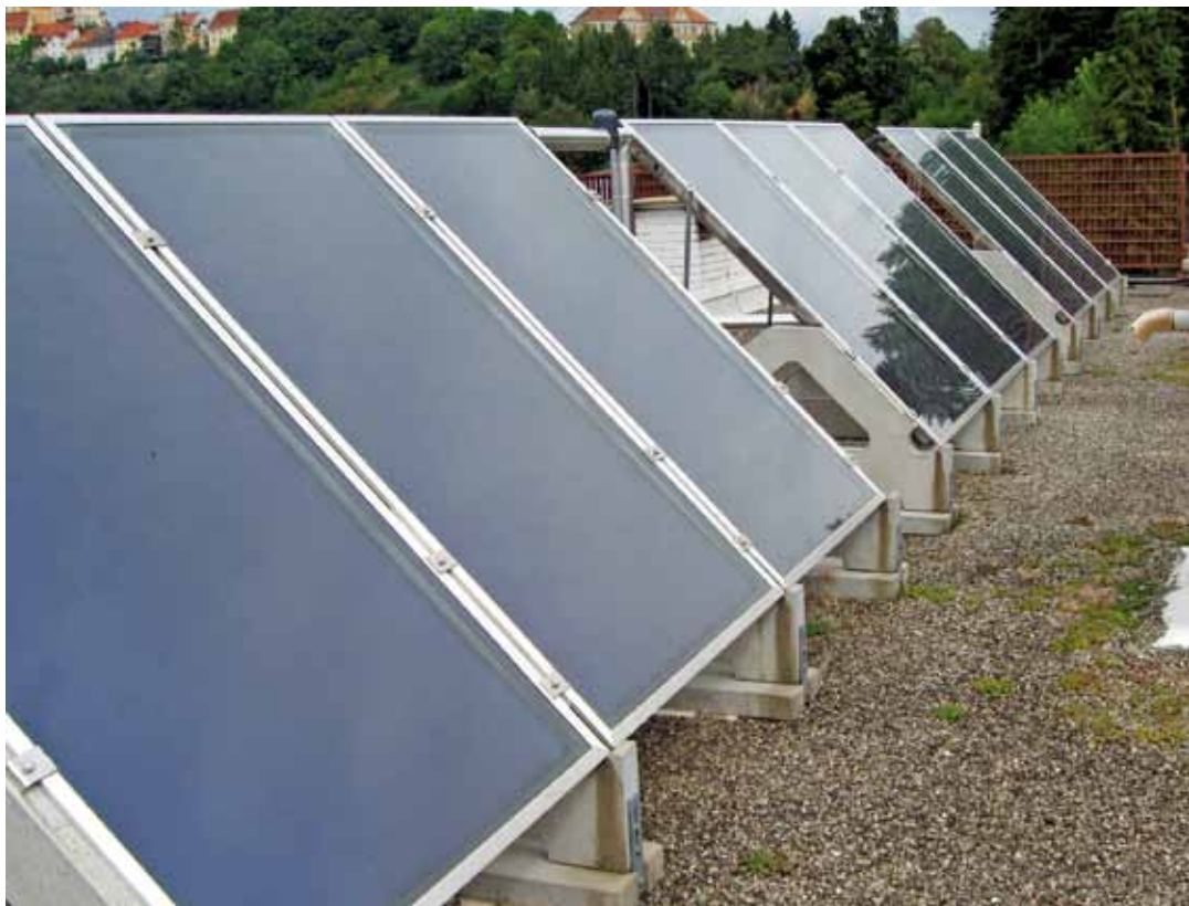
Slika 7 Sprejemniki Sonnenkraft SK500N ECO, vgrajeni na ravni strehi večstanovanjske zgradbe, v obratovanju od leta 2007
