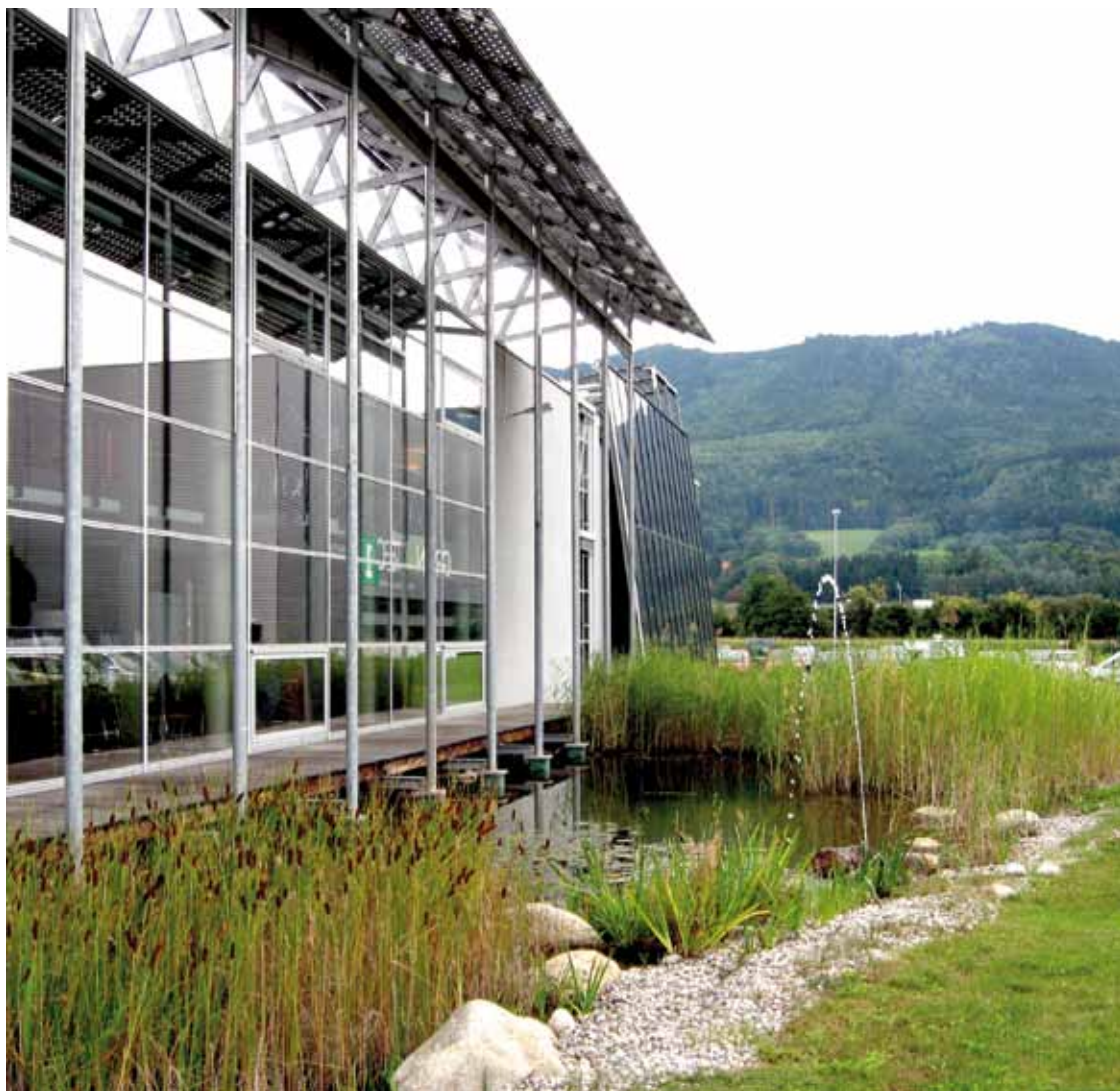
Slika 4 Upravno poslopije Sonnenkratz: fotovoltaični paneli, toplovodni fasadni grelnik, biotop, osvetljevanje prostorov z dnevno svetlobo ...
