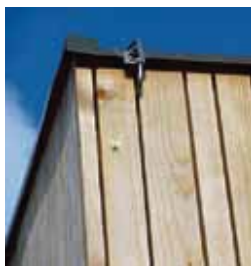
Slika 2 Strelovod, skrit za leseno fasado
