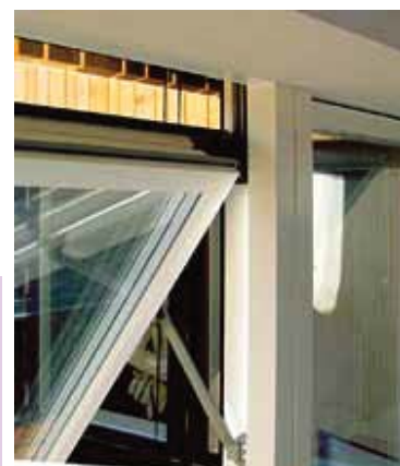
Slika 19 Odprto fasadno okno z vertikalnim odpiranjem
