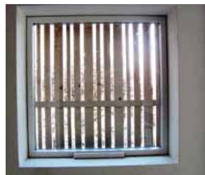
Slika 6 Okenska rešetka iz masivnih lesenih letev preprečuje vstop nepovabljenim gostom ob nočnem prezračevanju
