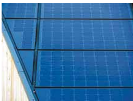
Slika 10 Fotovoltaični moduli so prirezani tako, da je streha povsem izkoriščena
